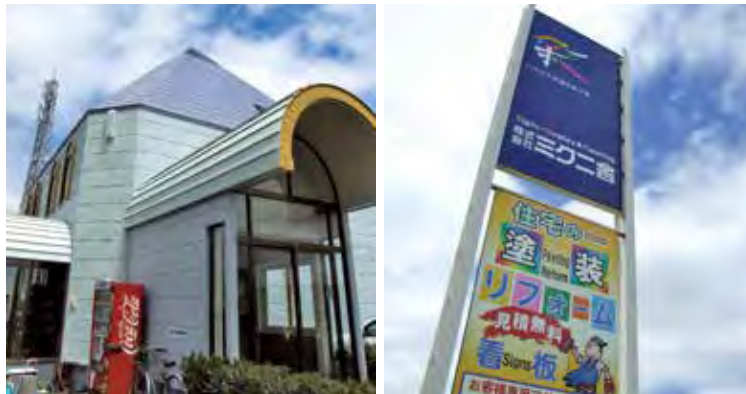
看板・サインの工事も手がける（建物は、ミクニ舎の本社）
