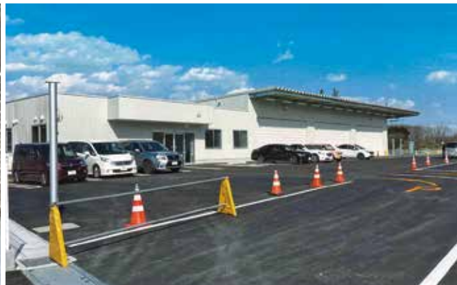
栃木県上三川町の新倉庫外観
